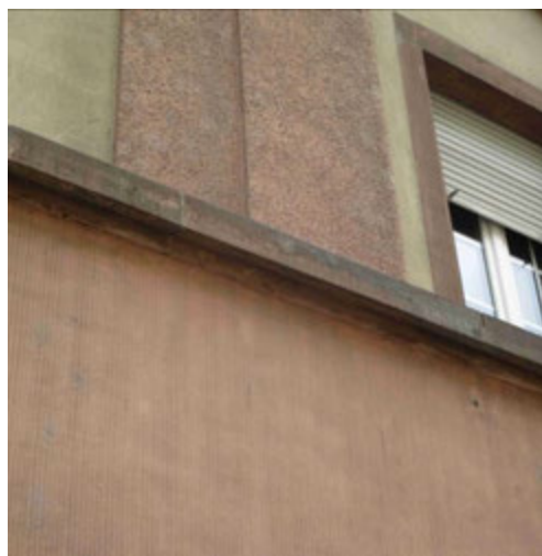
Enduit à forte rugosité posé à la tyrolienne (à gauche) ; enduit strié à rez-de-chaussée et enduit rustique sur pilastres (au centre) ; fausse chaîne à joints-refends réalisée sur l'enduit frais et plate-bande à la tyrolienne (à droite).
