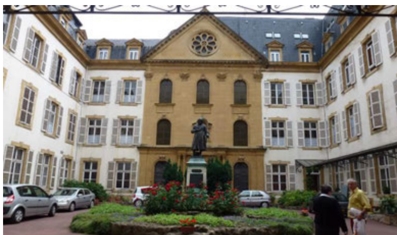
Cour de l'ancienne maternité Sainte-Croix et façade de la chapelle.
