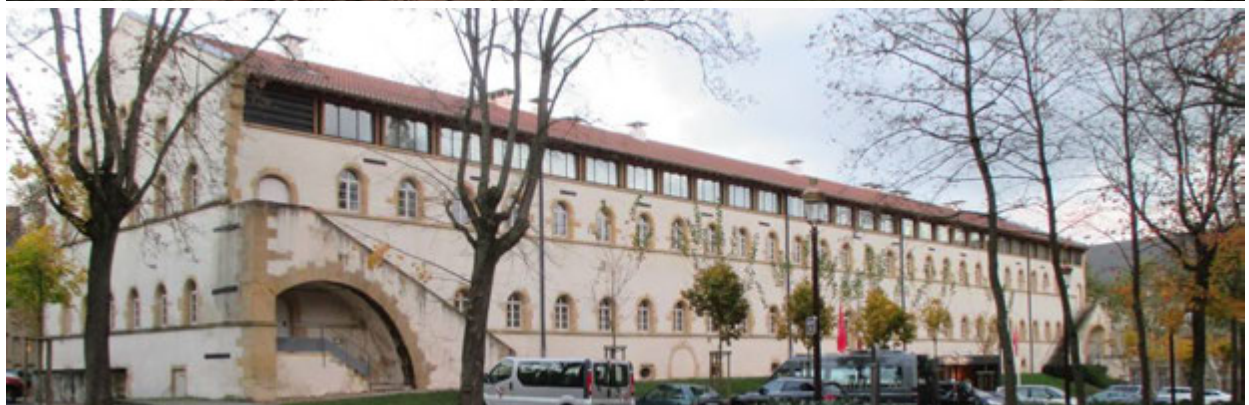
Le magasin aux Vivres, actuellement transformé en hôtel de luxe, après une campagne de travaux en 2005.
