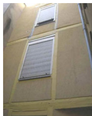
Exemple d'extension en pan de bois construite sur cour à la fin du XIX e siècle ou au début du XX e siècle (5 rue des Parmentiers).
