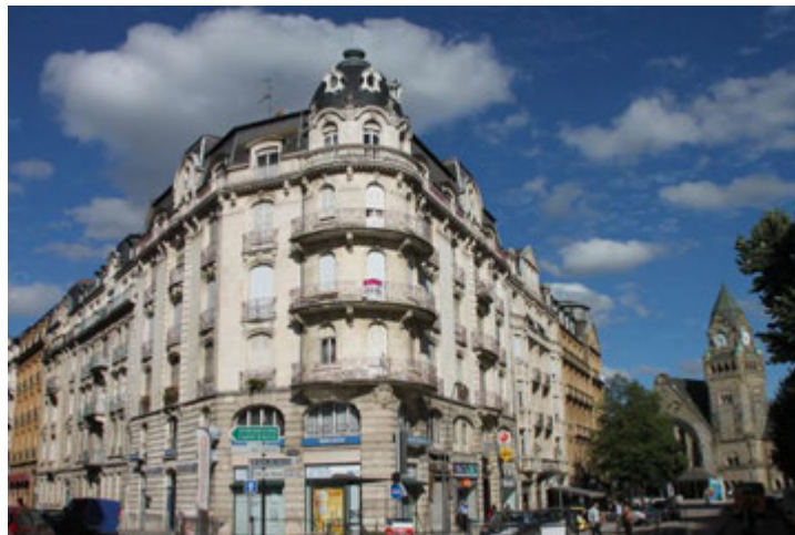
14, rue Charlemagne/16, rue Gambetta. Le « Coin français ». Ces immeubles néo-Louis XV et néo-Louis XVI en pierre de Lérouville tranchent avec la façade de la gare, au loin.
