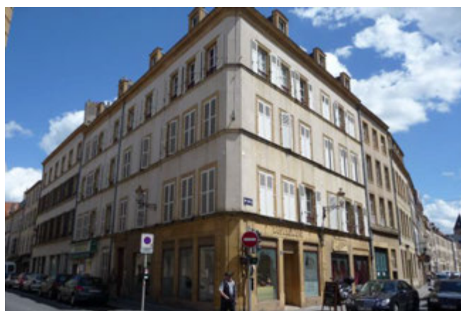
7-9, rue de la Hache / 14, rue Mazelle. Immeuble de rapport du milieu du XIX e siècle.
