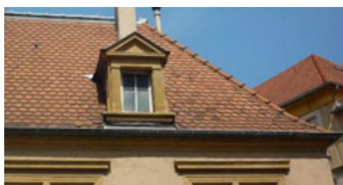
Tuile écaille ancienne de type bourguignon, châssis de toit récent en second rang à droite, réfection récente à gauche.
