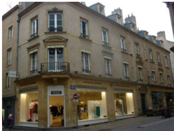
2, rue Dupont-des-Loges. Immeuble « placard ».
