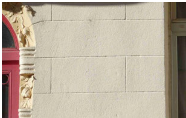
Exemples de traitement des enduits dans la Nouvelle-Ville : faux appareil (ci-dessus), stries droites (ci-contre), stries ondulées et joints-refends (à droite). Cette diversité est l'une des richesses du décor des immeubles de l'Annexion et de l'Entre-Deux-Guerres.
