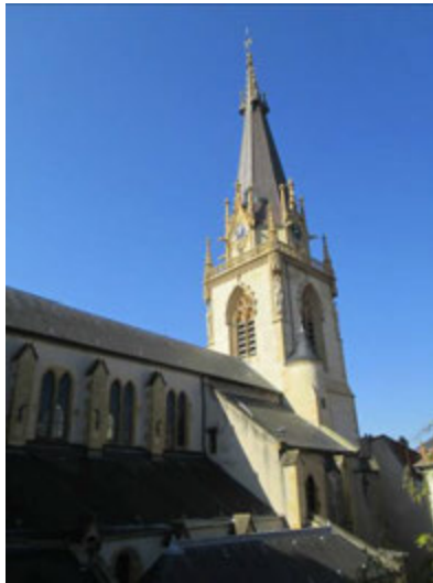
L'église Saint-Martin, vue depuis le presbytère. Le clocher a été rétabli en 1887 par Conrad Wahn.
