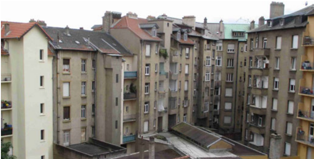
Ensemble de façades arrière dans l'ilot 113.
