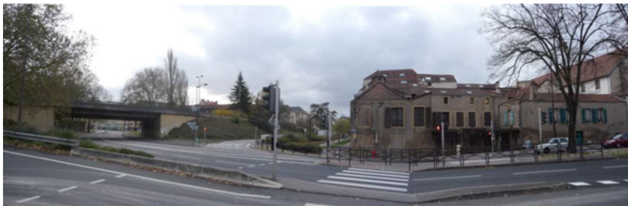
Entrée est du centre historique depuis le boulevard Victor Demange
