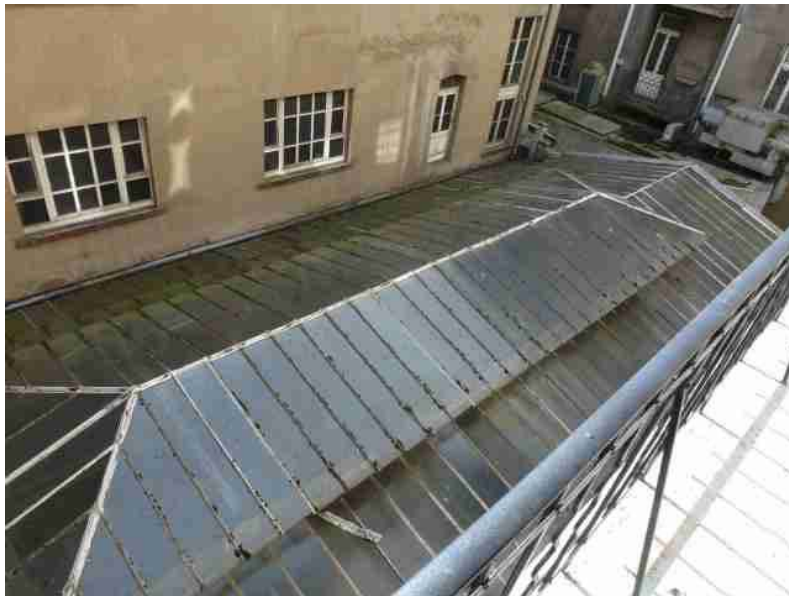
Verrière en milieu de parcelle sur l'espace situé entre un grand immeuble et son bâtiment secondaire.
