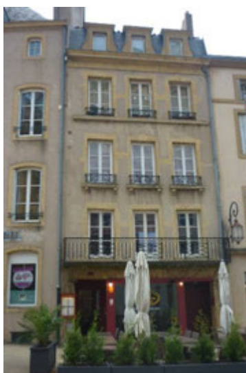
11, place de Chambre. Maison de la fin du XVIII e siècle.
