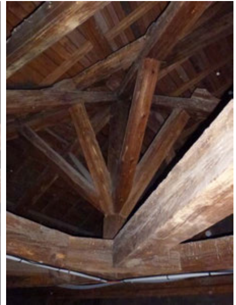
Exemple de charpente (au 1 rue Haute-Pierre) dont l'enchevêtrement permet un grand dégagement de l'espace disponible sous les combles.
