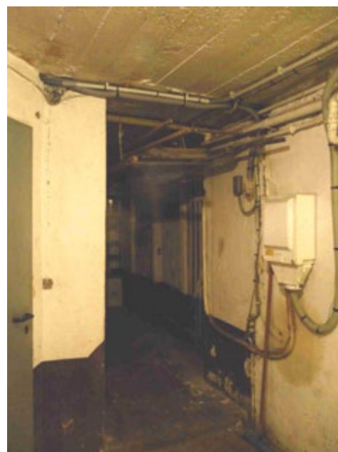
Un couloir de cave, au 7 rue du Sablon.
