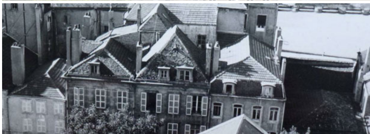
Evolution des couvertures et de leurs percements : rue Sous-Saint Arnould, vues prises de la vigie du cercle des Officiers. En haut, photo actuelle, en bas, années 1960 (archives STAP).
