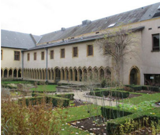
Intérieur du cloître du couvent des Récollets. Les bâtiments abritent l'Institut européen d'écologie.
