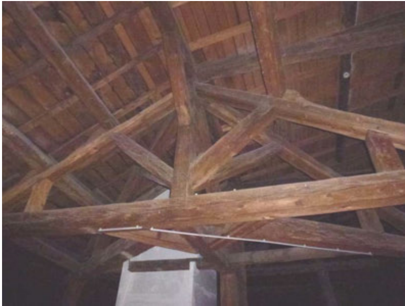
Exemple de charpente (au 1 rue Haute-Pierre) dont l'enchevêtrement permet un grand dégagement de l'espace disponible sous les combles.
