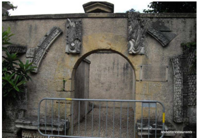
Les vestiges du portail présenté ci-contre et d'autres éléments prélevés dans l'ancienne abbaye Sainte-Marie-aux-Nonnains ont été replacés sur le mur de la terrasse du palais du Gouverneur.
