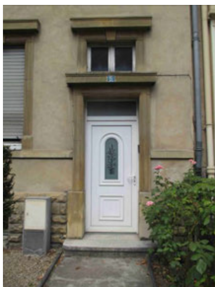
Rabotage d'éléments sculptés et pose d'un enduit inapproprié (à gauche), pose de menuiseries en PVC de série en rupture avec l'écriture architecturale (au centre), remplacement des vantaux et du portillon d'une porte cochère par un dispositif non qualitatif.
