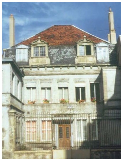
La tuile canal couvrait traditionnellement les maisons messines dont les toits ont de faibles pentes, ici place de Chambre. (© Fonds Prillot, médiathèque de Metz Métropole).
