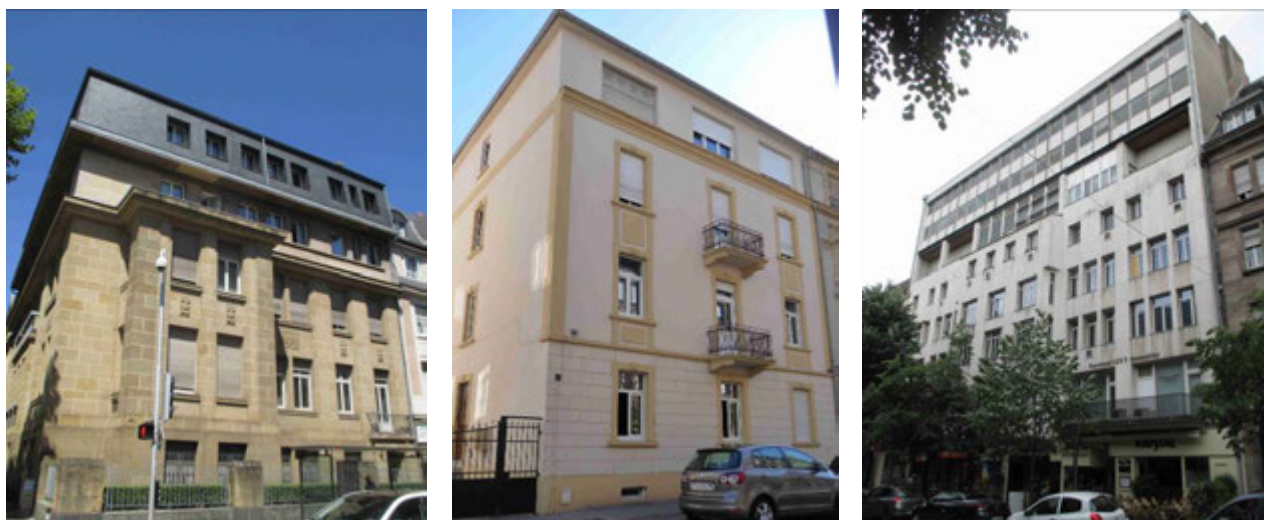
Surélévations mal intégrées ou non cohérentes avec le type traditionnel, voire couplées à un rhabillage de la façade (comme à droite, sur le Kristall Palast).
