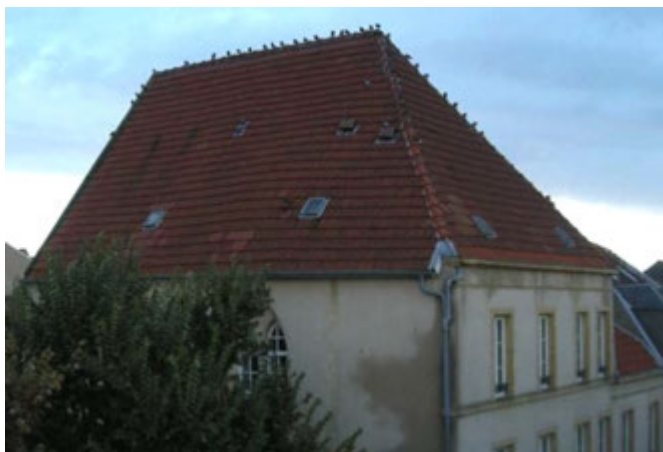
Couvertures à trois ou quatre versants à pentes fortes et étage d'attique à droite, tuile mécanique à double côte et vasistas anciens à gauche, ardoise écaille et petites lucarnes bois ajoutées dans le versant à droite.
