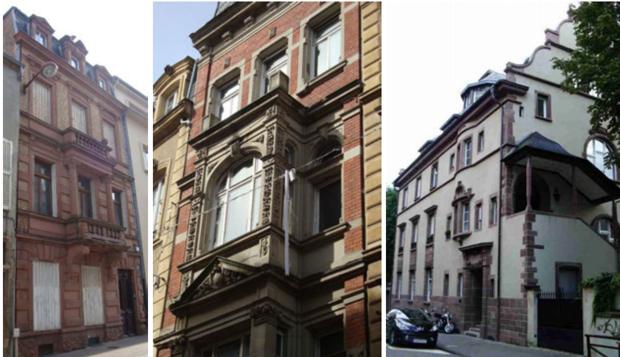
Grès rose et brique (6 rue aux Ours, à gauche) ; grès beige et brique (53 rue Serpenoise, au centre) ; grès beige et enduit (19-19bis rempart Saint-Thiébault, à droite).
