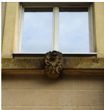
2-12, en Nicolairue. Clefs sculptées XVIIIe provenant de l'ancien hospice Saint-Nicolas, remontée sur un immeuble résidentiel.
