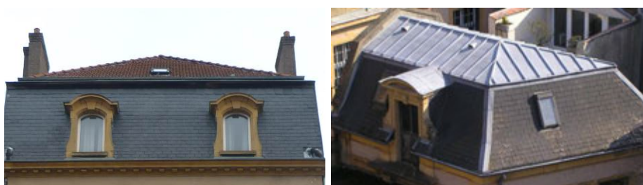
L'ardoise est surtout visible sur des brisis, souvent associée à la tuile pour les terrassons (ou au zinc pour les bâtiments construits à partir du XIX e siècle).
