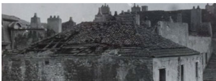
La tuile canal couvrait traditionnellement les maisons messines dont les toits ont de faibles pentes, ici rue du Haut-de-Saint-Croix, sur un bâtiment aujourd'hui restauré. Sur les parties basses de la couverture, au contact du chéneau encaissé, la tuile canal avait déjà été remplacée par de la tuile mécanique (Archives du STAP de Moselle).
