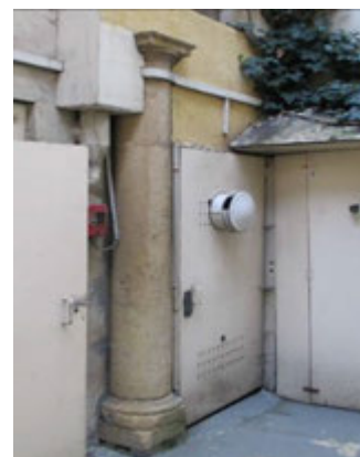
7-9, rue du Neufbourg. Colonne à chapiteau posée dans une cour après opération de rénovation. Elle se perd entre les réseaux et édifices techniques.
