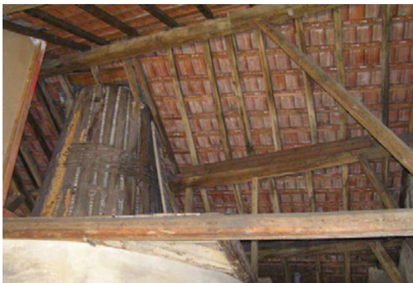
Exemple de charpente très reprise intégrant le cône d'éclairage zénithal de la cage d'escalier, réalisé en lattis plâtré (10 rue Maurice-Barrès). Les irrégularités observables dans l'implantation des pannes sont dues au rattrapage nécessaire de la forme trapézoïdale du bâtiment.
