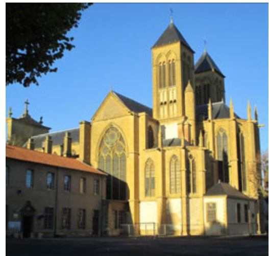
Chevet de l'ancienne abbatale Saint-Vincent.
