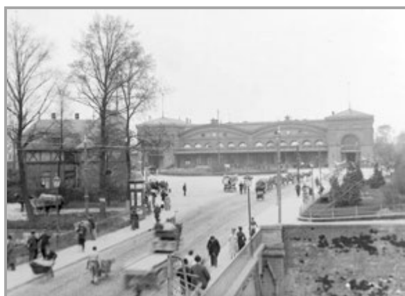
Le parvis de l'ancienne gare. La vue est prise avant 1902 puisque les fossés ne sont pas encore comblés.
