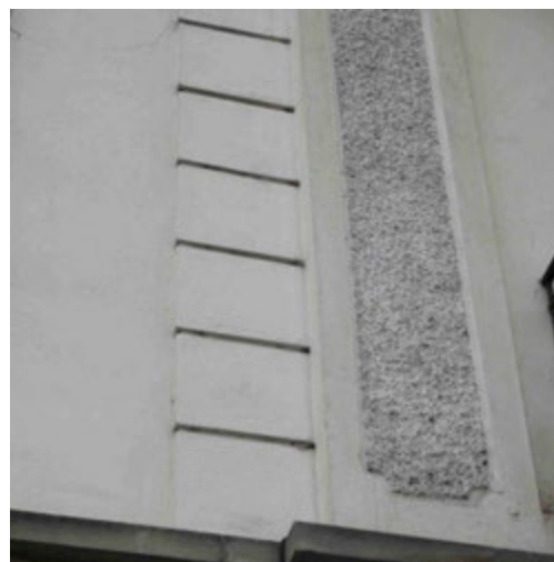
Enduit à forte rugosité posé à la tyrolienne (à gauche) ; enduit strié à rez-de-chaussée et enduit rustique sur pilastres (au centre) ; fausse chaîne à joints-refends réalisée sur l'enduit frais et plate-bande à la tyrolienne (à droite).
