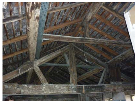
Exemples de charpentes messines courantes (26 rue du Neufbourg, multiples supports nécessaires pour une noue ; 30 place Saint-Louis, faible pente, réalisation traditionnelle. Ci-contre, au 4 rue Saint-Vincent, un exemple de charpente messine pour une couverture à forte pente.
