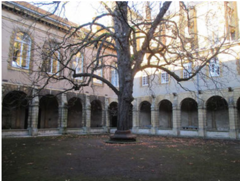
Lycée Fabert, cloître de l'ancienne abbaye Saint-Vincent, construit au début du XVIII e siècle. Une aile est de l'architecte Jean Spinga (1705).
