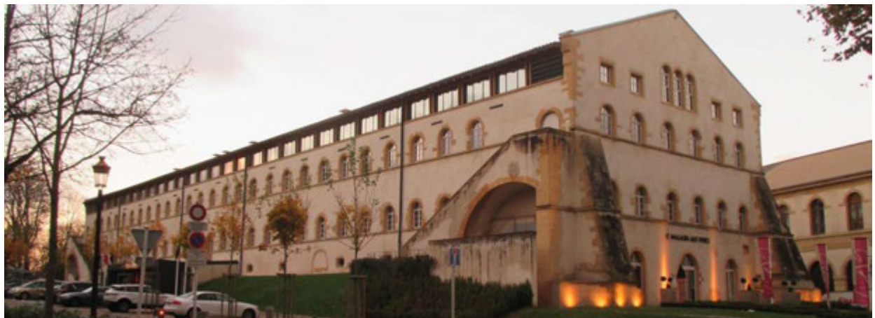
Le magasin aux Vivres avant la destruction des vestiges de l'abbaye Sainte-Marie-aux-Nonnains et la construction du palais du Gouverneur. On remarque l'attique ajouté en 1873. © Bibliothèque-Médiathèque de Metz-Métropole, fonds Prillot.
