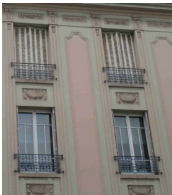
Enduit moulé en ciment, remplaçant généralement à partir des années 1920 les parties traditionnellement sculptées sur les façades dans la Nouvelle-Ville : plates-bandes et guirlandes (à gauche) ; relief en creux dans le goût Art nouveau (ci-dessus en haut) ; buste de jeune homme sur un immeuble Modern style (ci-dessus en bas).
