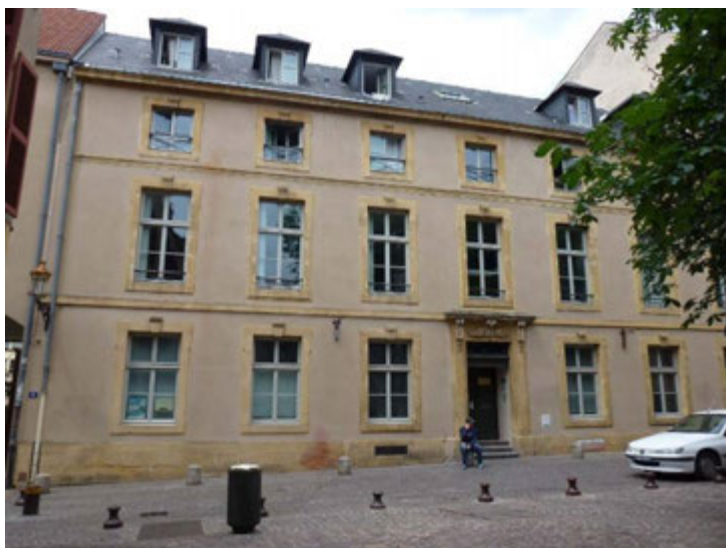
2-4, rue du Haut-de-Sainte-Croix. Opération de façadisme des années 1980 sur un immeuble protégé (façade et toiture) au titre des Monuments historiques.
