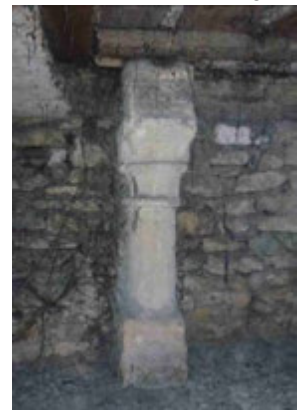
6 rue du Pont-Moreau
