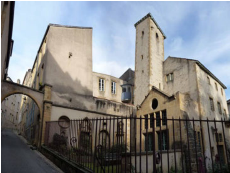
2, rue d'Enfer (vu depuis la Jurue). Chapelle Saint-Genest, aménagée dans un logis roman du XII e siècle, attribuée à l'Ordre de Malte au XVI e siècle. Le clocher date de cette époque.
