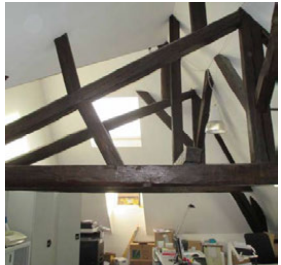
Exemple de charpente (au 1 rue Haute-Pierre) dont l'enchevêtrement permet un grand dégagement de l'espace disponible sous les combles.
