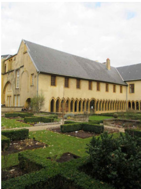
Ancien couvent des Récollets, au 1, rue des Récollets. Ce monument emblématique de Metz a été l'objet d'une opération de façadisme lors de son aménagement en équipement en 1972. A l'exception des façades protégées à la même date, d'éléments lapidaires conservés dans les galeries du cloître et de la salle capitulaire (non protégée), les intérieurs ont été très profondément remaniés et la façade sur la rue des Murs totalement reconstruite.
