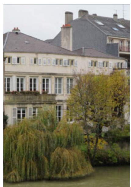
14-16, rue de la Haye. Façade arrière et jardin d'un hôtel du XVIIe siècle en bord de Moselle.
