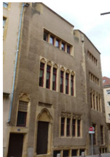
8-10, rue du Haut-de-Sainte-Croix. Opération de façadisme des années 1980 sur un immeuble protégé (façade et toiture) au titre des M.H., après restauration/restitution de la façade. A l'exception des éléments inscrits M.H., seuls les structures porteuses des caves et la première volée de l'escalier ont été conservées.
