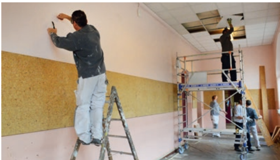
↑ Rénovation des salles de classe du groupe scolaire Debussy-Chanteclair.
